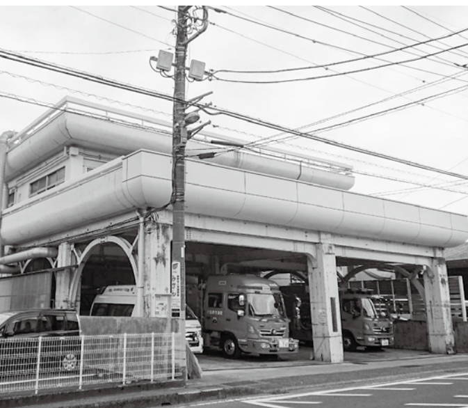
老朽化し建替えが予定される消防松田分署
