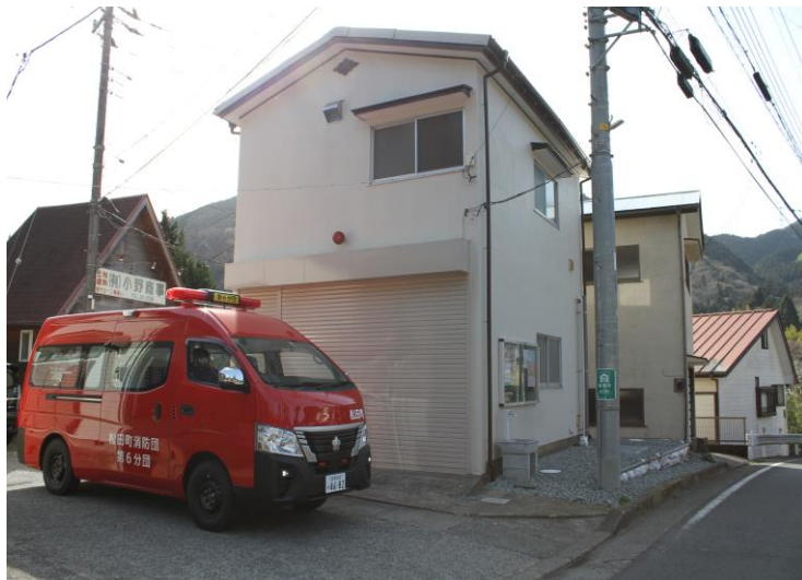
長寿命化改修工事を行った松田町消防団第6分団詰所と 小型動力ポンプ式ワンボックスタイプ積載車
