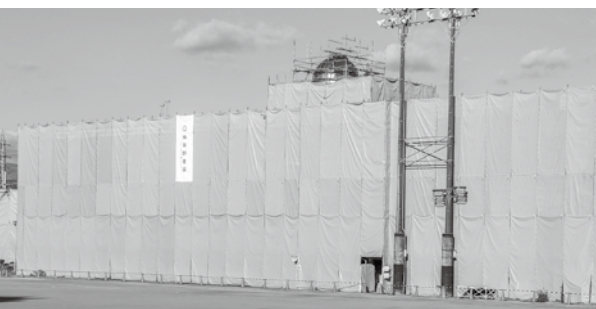
大規模改修工事中の松田中学校校舎
