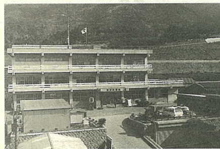
昭和39年 現役場庁舎完成
