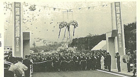
昭和44年 東名高速道路全線開通
