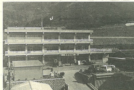
昭和39年 現役場庁舎完成
