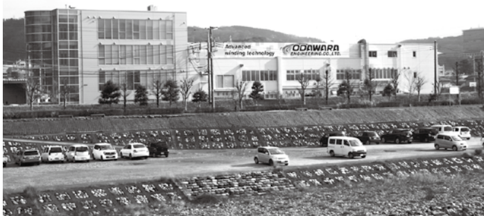
(株)小田原エンジニアリングの新工場 (H26年3月完成)
