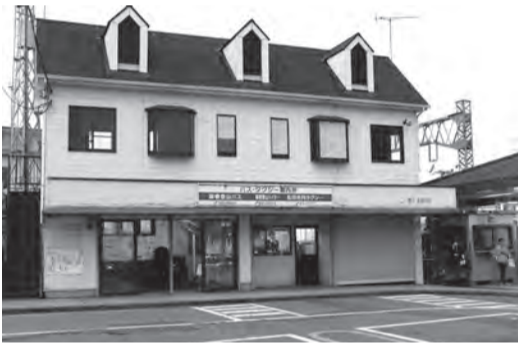
↑工事前の店舗（平成26年11月7日撮影）
