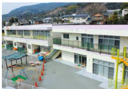
↑右側建物が増築した園舎
