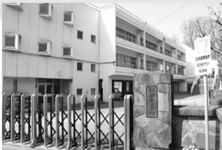
↑建設されて42年が経過した松田小学校
