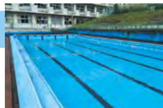
寄中学校プール
