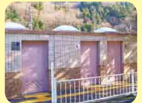
多目的トイレ
