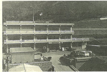
昭和39年 現役場庁舎完成
