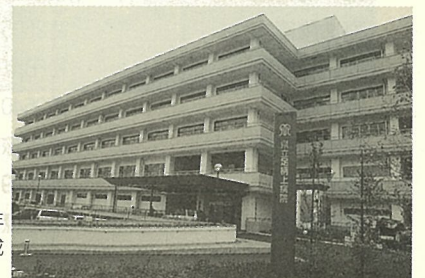
平成13年 県立足柄上病院新3号館完成
