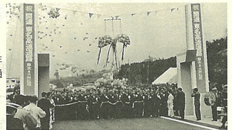
昭和44年 東名高速道路全線開通
