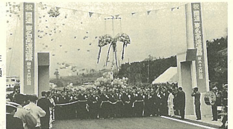
昭和44年 東名高速道路全線開通
