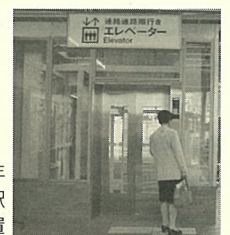
平成15年 小田急線新松田駅 エレベーター設置
