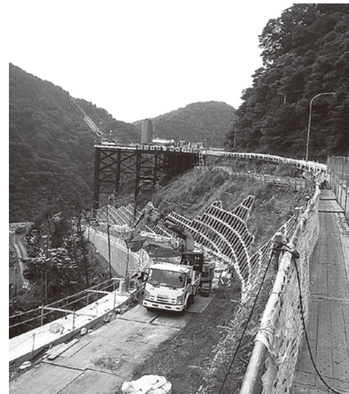
萱沼地区付近の新東名建設工事現場
