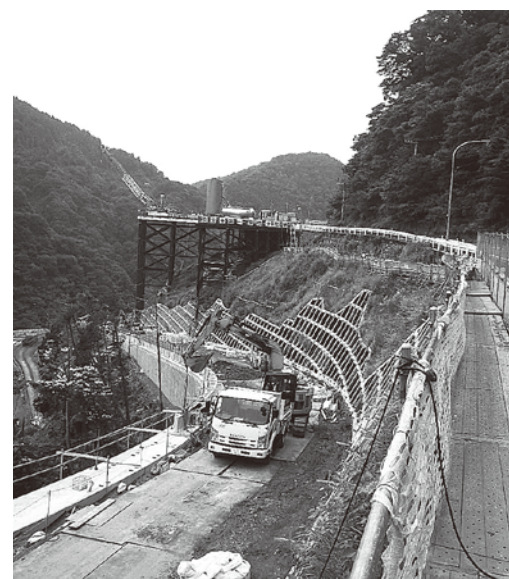
萱沼地区付近の新東名建設工事現場
