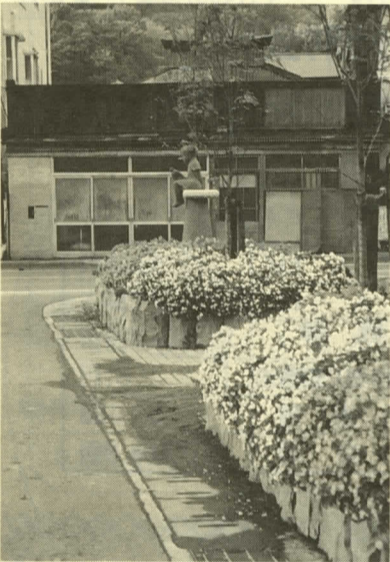
道路アメニティ整備工事
