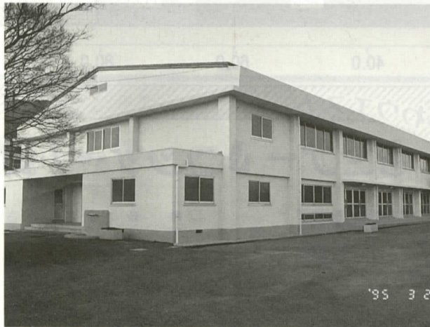
整備工事が終わった町体育館
