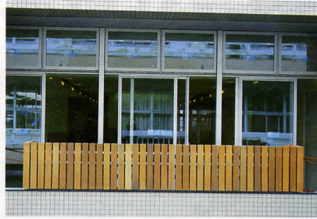
写真:陶器製外部ルーバー (撮影日:平成18年2月21日)
