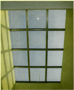
▼ソーラートップライト(光を通しながら発電も行います)
