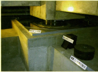
▲免震装置(地下の見学スペースで見学できます)
