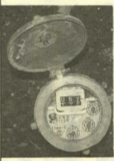
水道メーター
