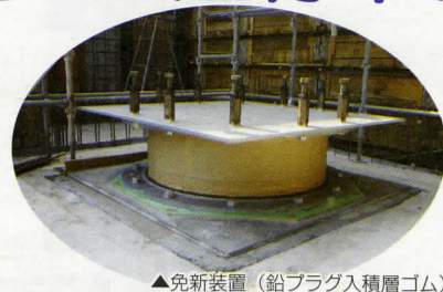
▲免新装置(鉛プラグ入積層ゴム)
