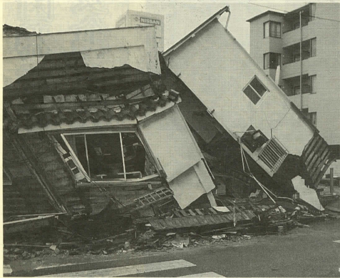
阪神・淡路大震災で倒壊した木造住宅
