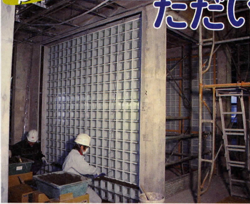
写真:2階エレベーター壁(施工中) 11月22日撮影
