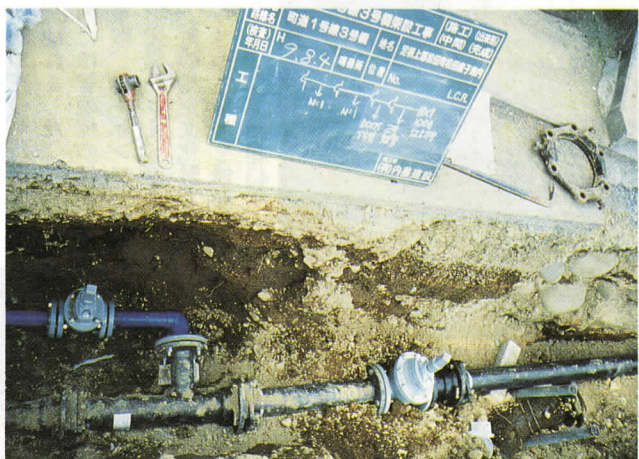
水道本管工事
