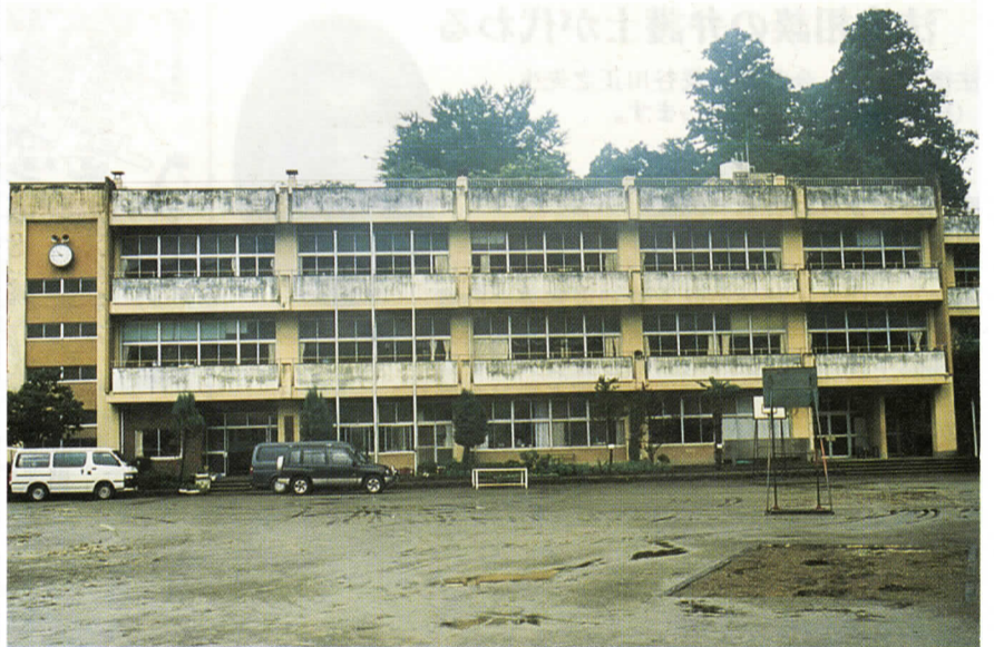
耐震工事を実施する寄小学校
