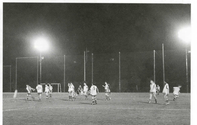
照明設備が設置されたみやま運動広場
