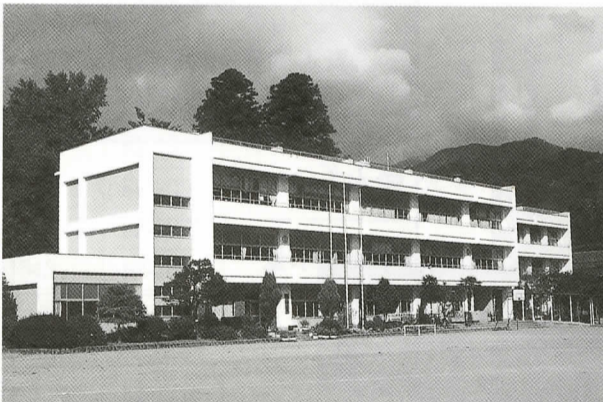
寄小学校校舎耐震補強工事
