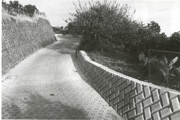
農道の整備工事
