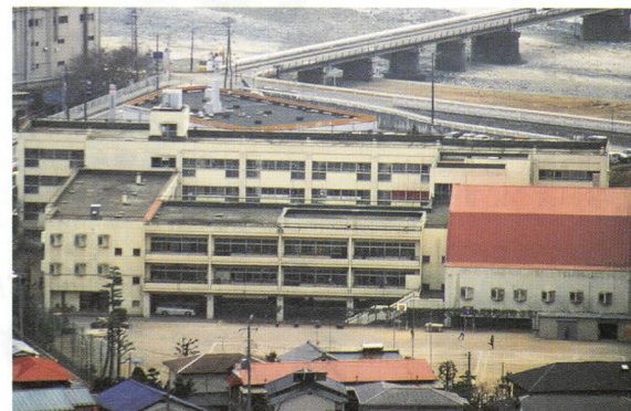
耐震補強工事をする松田小学校校舎・屋内運動場 昭和 48 年 3 月・49 年 2 月完成
