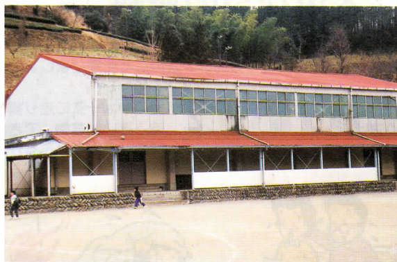
平成 11・12 年度で建て替える寄中学校屋内運動場 昭和 47 年 3 月完成
