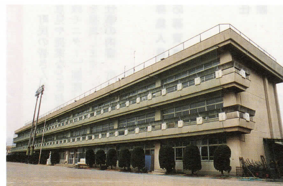
耐震補強工事のための設計書を作る松田中学校校舎 昭和 46 年 3 月完成
