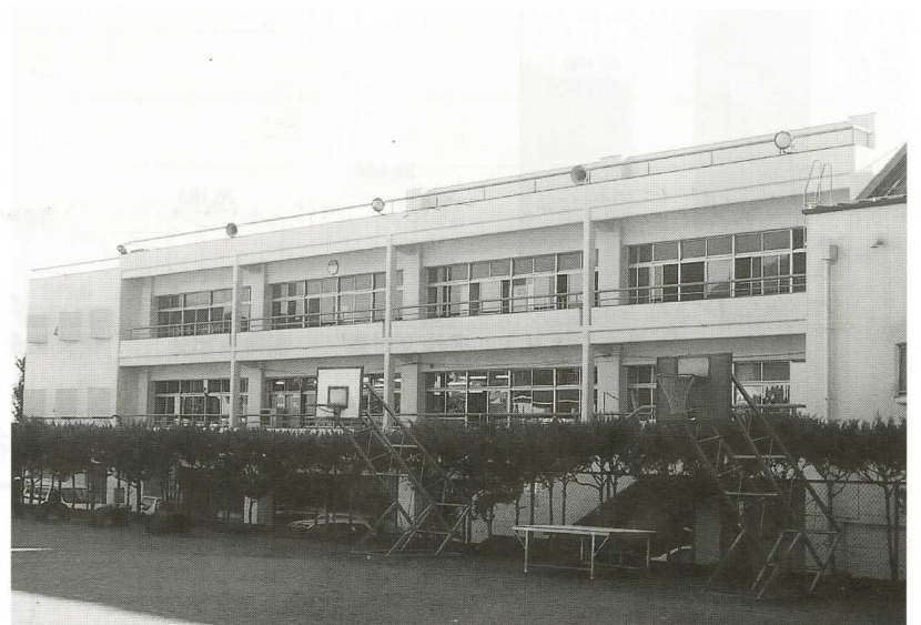
耐震補強工事の終了した松田小学校
