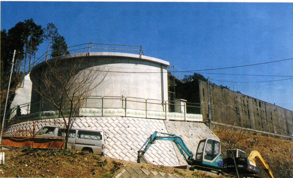
河南沢配水池整備：手前の円柱状のものが平成 11 年度完成の 800 トンの貯水槽。12 年度は右側の箱状のものを取り壊し、1200 トンの貯水槽を造ります。
