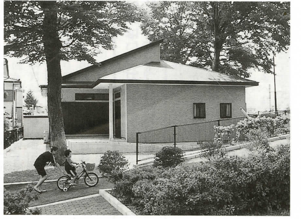
△平成11年度に完成した店屋場地域集会施設
