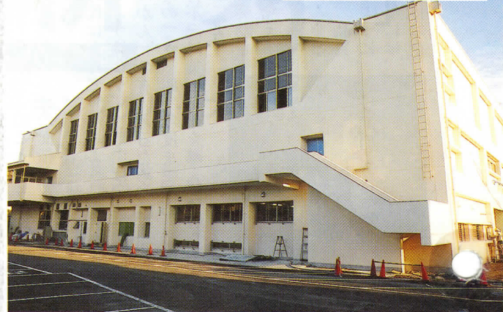
▲外観では、建物横にあったスロープとアリーナ窓部分の横格子が取り払われました。この改良により、アリーナは以前よりもだいぶ明るくなりました。（右上の写真は、改良前）
