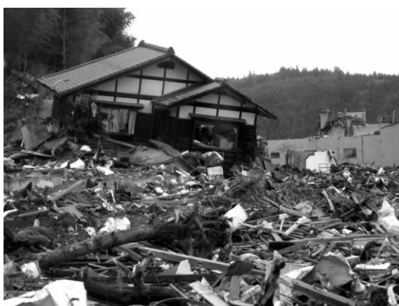
津波によって倒壊した家
