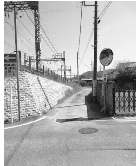
今後整備が予定される町道2-9号線
