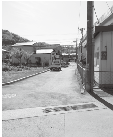
拡幅された町道23号線
