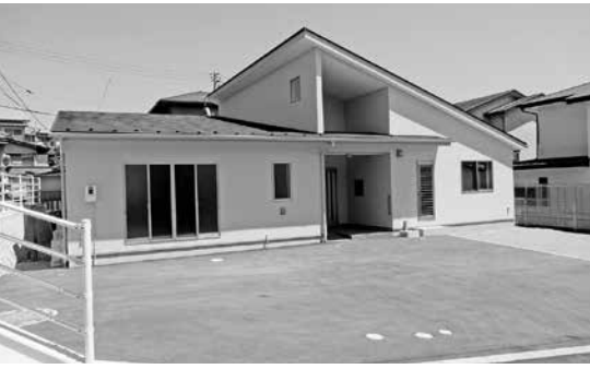
完成した介護予防・生活支援拠点施設
