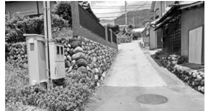
マンホール内の汚水ポンプ交換(城山地区)
