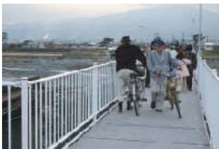
▲十文字橋仮設橋が完成、人や自転車が通行
