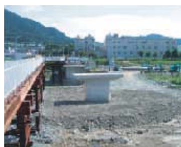
▲橋脚が完成、橋桁が架かるのを待つ
