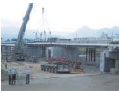
▲橋桁が架かり、十文字橋の姿が一年ぶりに
