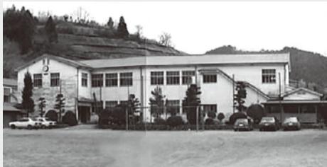
昭和61年完成の新校舎
