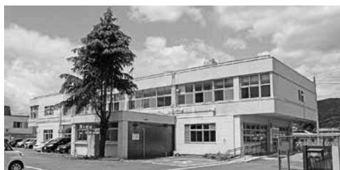
松田町創生推進拠点施設の外観
