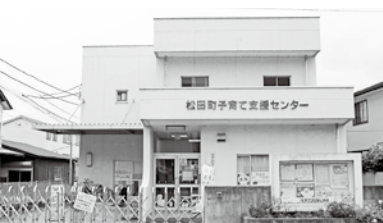
小規模保育所に改修予定の施設
