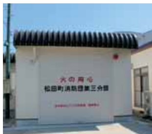
▼消防ポンプ自動車兼消防資機材置場
