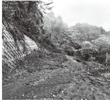
土砂崩落の様子
