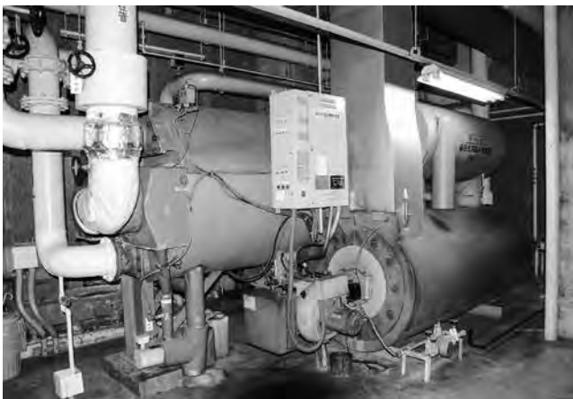
文化センターボイラー
