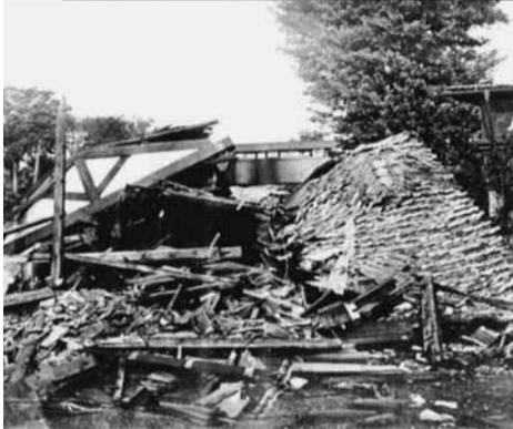
▲大正12年 関東大震災で 崩壊した東海道本線(当時) 松田駅
