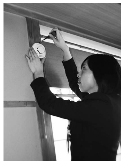
高齢者宅に火災警報器を設置
