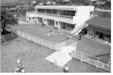
▲保育所へ改修予定の第二幼稚園
