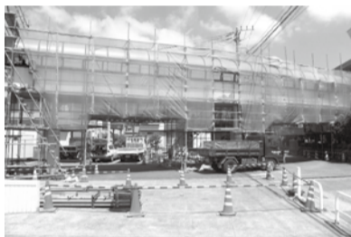
《松田中の渡り廊下改修》
