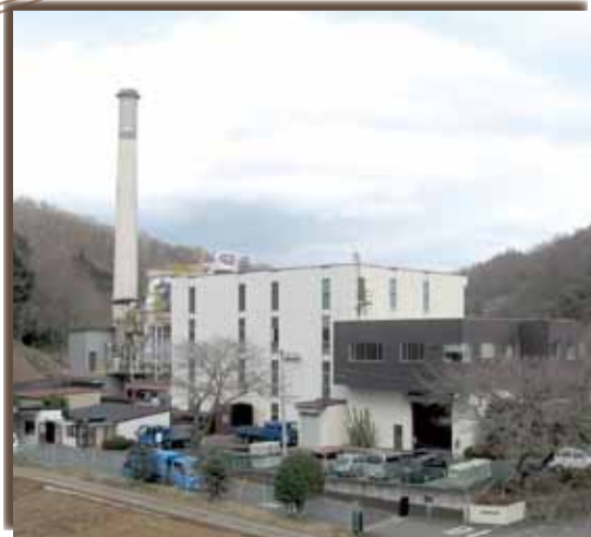
▲大井美化センター。熱した砂で焼却する方式で、ごみを効率的に燃やしています
