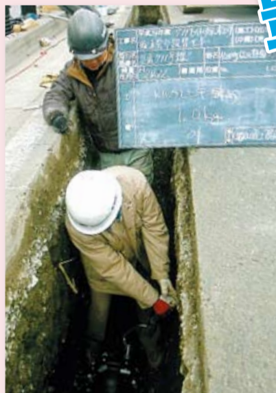
順次配水管の布設替え工事を実施しています || 昨年12月、松田惣領の県道711号で
