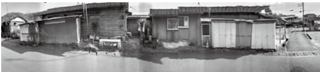
松田町営住宅(戸建て)
