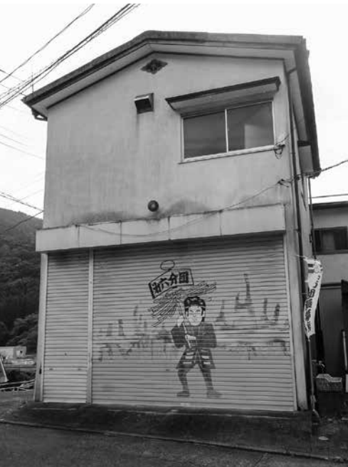
消防第6分団詰所
