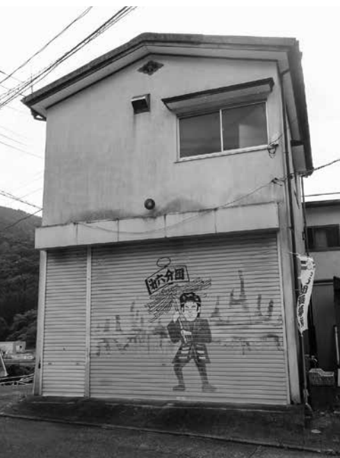
消防第6分団詰所
