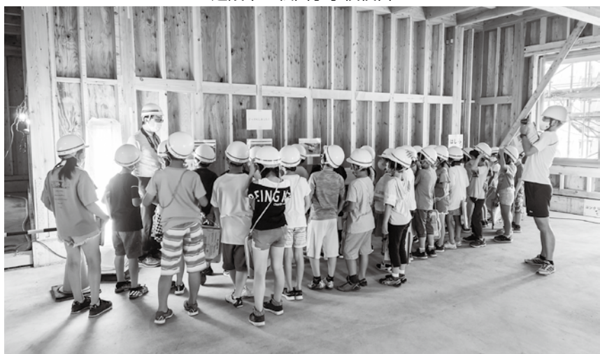
建設中の松田小学校校舎
